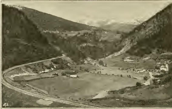
Abb. 48. Kehrschleife der Brenner-Bahn im Pörschthale.
